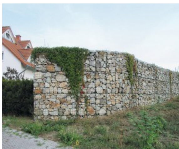
Samostatně stojící gabionová PHC výšky 3–4 m vyztužená ocelovými sloupy (Polsko, Łódž)
