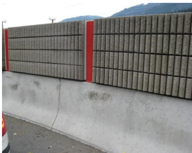
Protihluková clona na svodidle, pohltivá (Rakousko)
