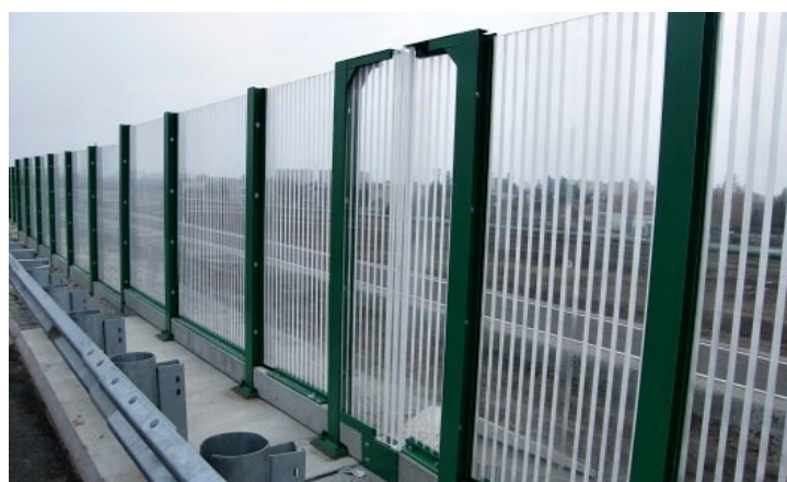
Ocelové sloupky kotveny přes patní desky přímo do římsy mostu
