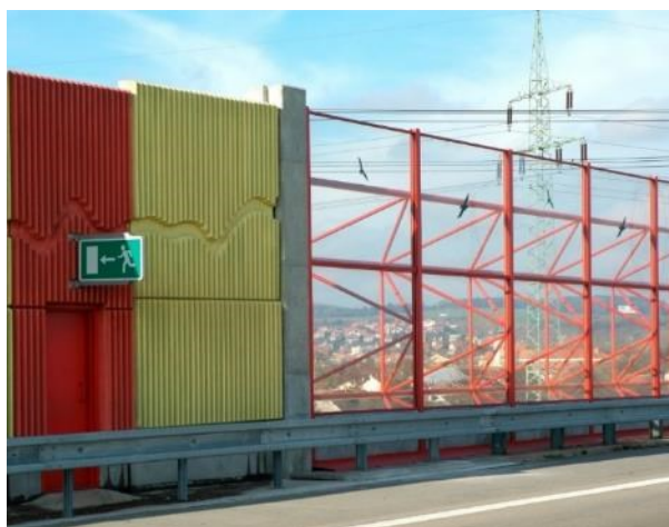
Kotvení PHC do mostní římsy, nosná konstrukce PHC vynesena mimo konstrukci mostu
