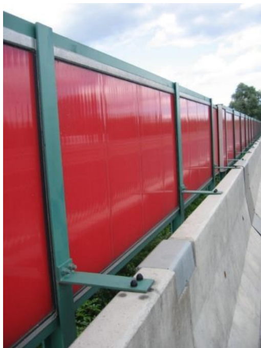
Protihluková clona na svodidle odrazivá
