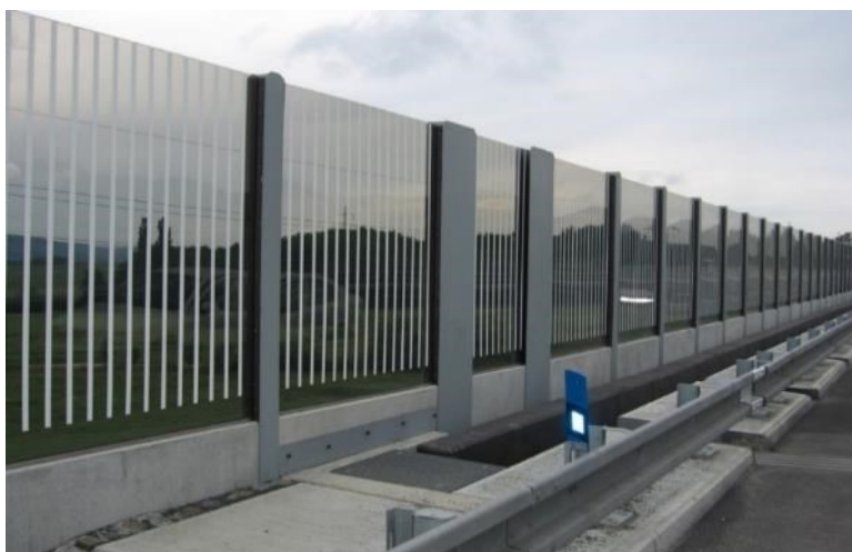
Kotvení PHC do mostní římsy, nosná konstrukce PHC vynesena mimo konstrukci mostu
