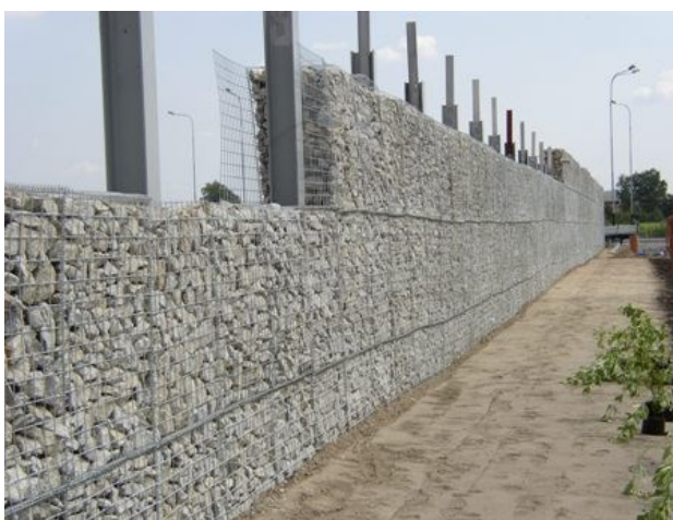
Samostatně stojící gabionová PHC výšky 3–4 m vyztužená ocelovými sloupy (Polsko, Łódž)
