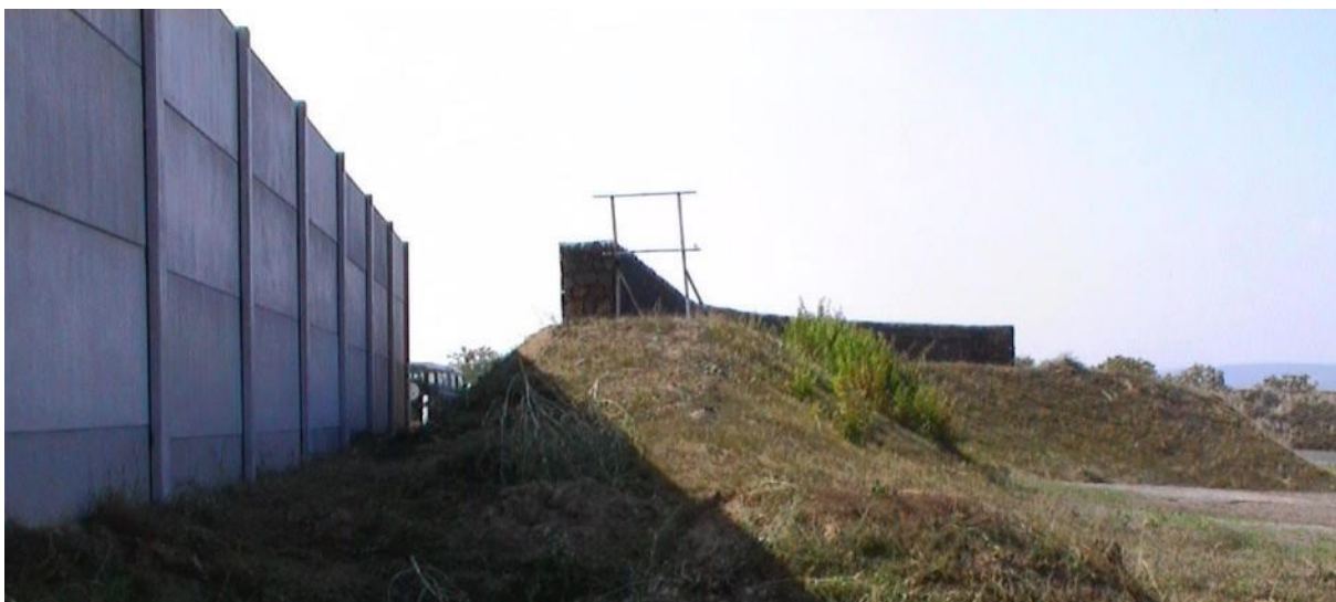
Gabion na zemním valu, překrytí s PHC
