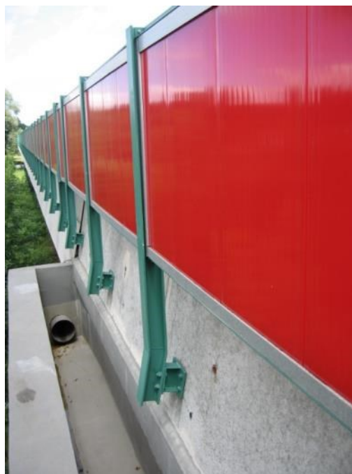
Protihluková clona na svodidle odrazivá
